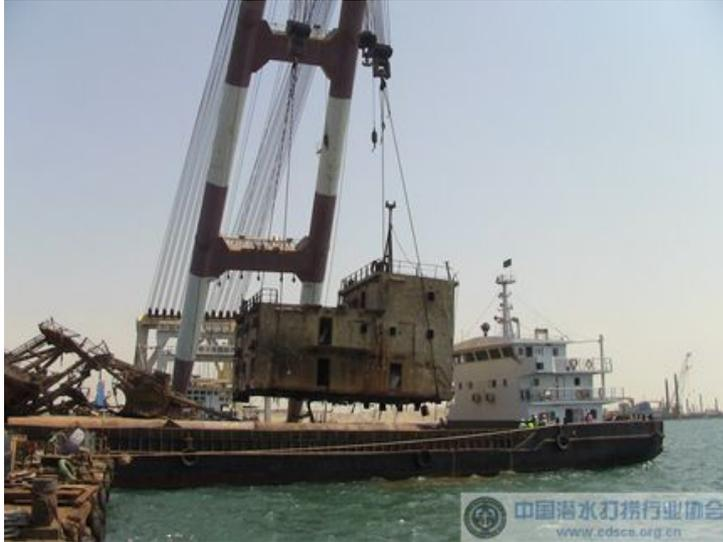
该生活楼自重 256t。甲板与生活楼之间空隙高约 70 厘米，潜水员要下潜 15 米的水下并钻到生活楼空隙内作业，需要用电氧切割 12 组减震垫 96 根螺栓和四角的连接板，施工难度很大。
