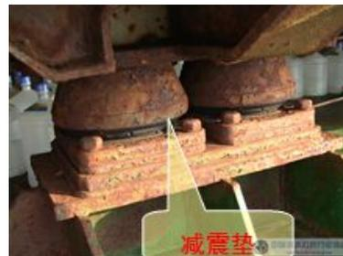
在水下电氧切割时底部桁架内容易堆积氧气，一旦引起爆燃将对潜水员自身有极大危胁。针对存在的安全问题，经组织潜水员们进行研究讨论后，确定在切割中采用由两名潜水员配合作业，一名潜水员负责切割，另一名潜水员采用高压空气稀释氧气给予配合的方法进行施工，经过潜水员 9 天的水下奋战，顺利完成了减震器螺栓和连接板切割，将生活楼成功打捞出水。（一航局一公司劳务水下分公司 王玖、徐福伟 投稿）
