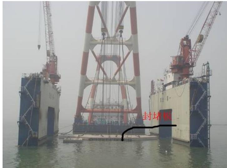
该项目为位于天津港南疆港区，取水终端为外型尺寸 27.6 米\*11.4 米\*3.7 米的空腔砼构件、总重 1335 吨。技术人员利用公司现有的 700 吨浮吊，采用对构件进出水口封堵、半潜驳下潜撤船，借助构件水中浮力（1235 吨）和 700 吨浮吊进行水中定位、安装。潜水员在整个过程中密切观察构件密封情况、协助浮吊和测量人员对构件进行水下定位，最后打开进水口和放气阀，取水终端平稳下放成功，全部数据满足设计要求。
