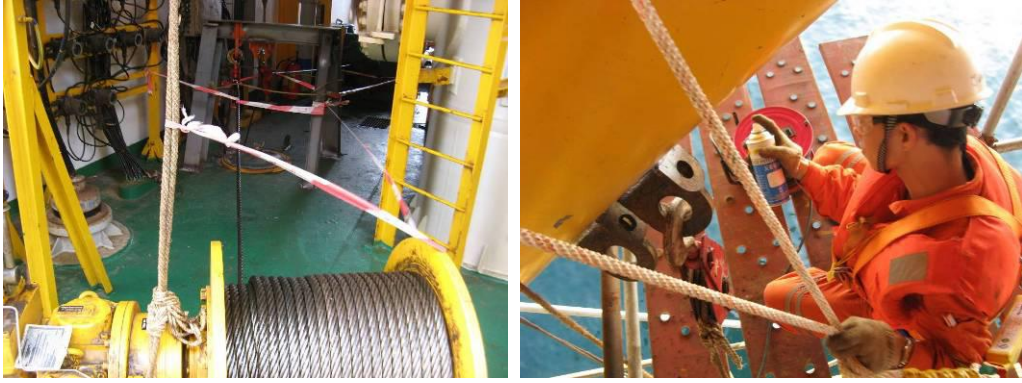
图1 绞车及吊点布置
