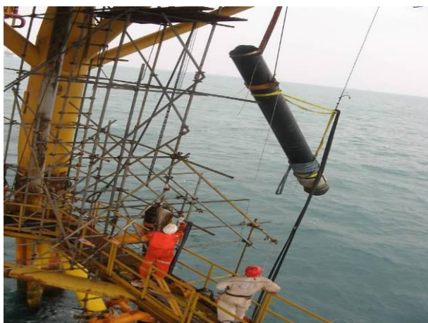
图13 水下弯管段吊装及组对
