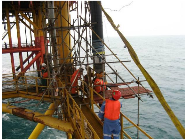
图14 两根管段组对焊接
