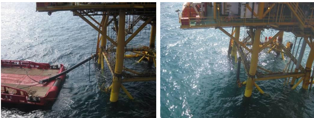
图10 绞车将水下弯管段吊装就位
