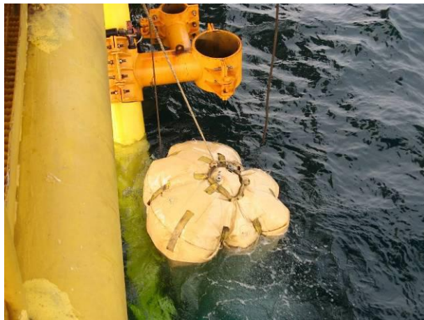
图5 通过信号绳将浮袋及立管卡子拖至安装位置附近
