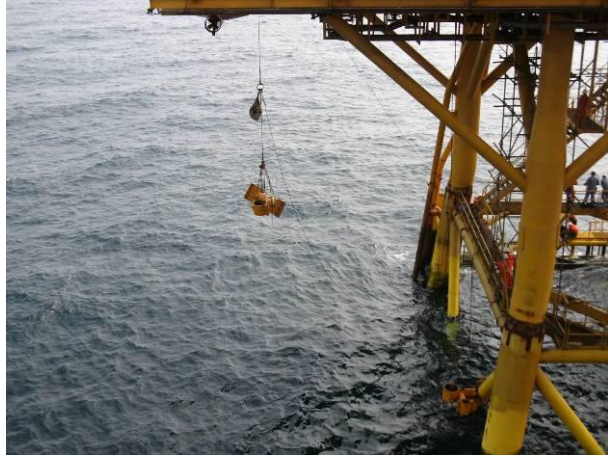
图3 立管卡子与浮袋吊装下放
