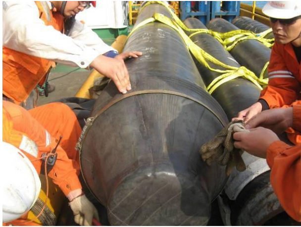
图8 增加橡胶防水堵头
