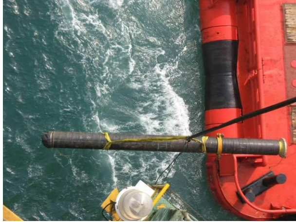
图16 平台吊机将4T直管段从拖轮吊起
