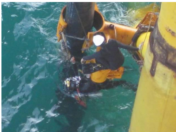
图11 潜水员临时固定水下弯管段
