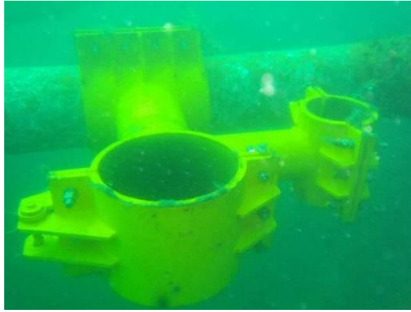
图7 立管卡子安装完成
