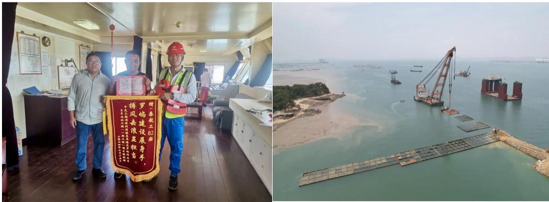
该码头是福建省莆田市第二个 40 万吨级码头，项目建成后将使整个港口提升至全国第三个拥有双 40 万吨级矿石船靠泊装卸的港口，也标志罗屿港将蜕变成我国东南沿海铁矿石码头第一港。江苏蛟龙在该项目中承担了关键任务——安装 28 件沉箱。该公司克服作业区水域深、潮差大，涨落潮期间流速快等困难，圆满完成任务，受到甲方和业主一致称赞。
